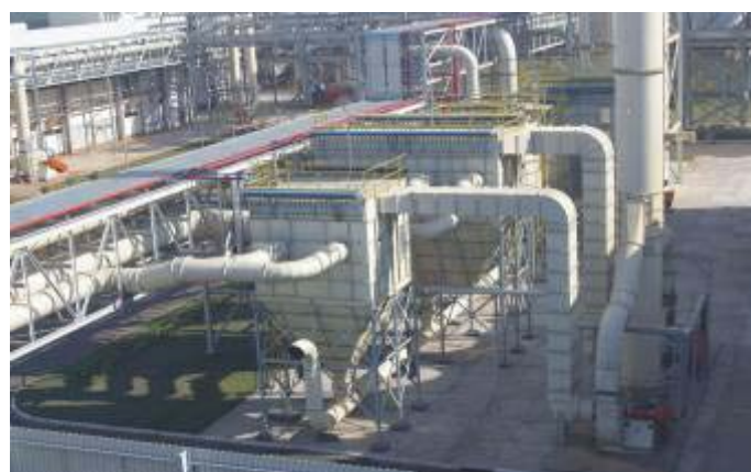
DURATEX – Botucatu – SP: Sistemas de despoejamento da fábrica de MDF.
