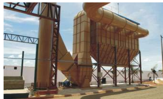
COPLANA – Jaboticabal – SP: Sistemas de despoejamento beneficiamento de amendoim.
